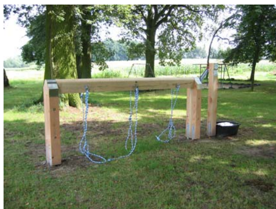
Foto 3: Neuer Anbindebalken an einer Reitstation
