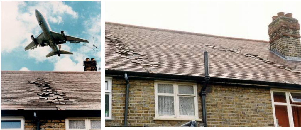
Bild 6. Von Wirbelschleppen verursachte Dachschäden an Häusern in der Einflugschneise des Flughafens London-Heathrow (aus Präsentation von Blackmore 1994).
