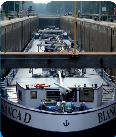
Afb. 1: Sluis Gleesen vlakbij Emsbüren, Dortmund-Eemskanaal
