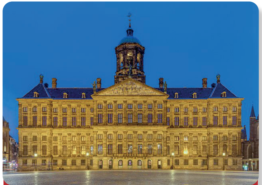
Afb. 3: Koninklijk Paleis Amsterdam, gebouwd uit Bentheimer zandsteen
