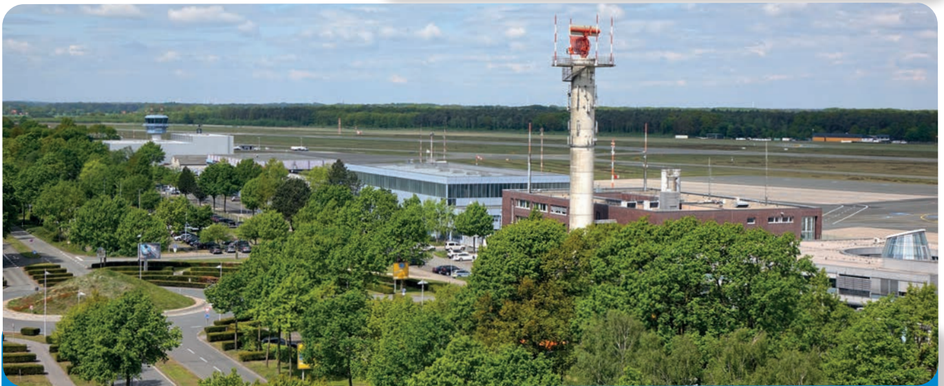
Afb. 2: Luchthaven / Flughafen Münster/Osnabrück
