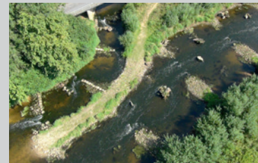
Umbau eines Querbauwerks und naturnahe Anbindung Nebenbach Hesseleinmündung, Ems, Warendorf-Einen
