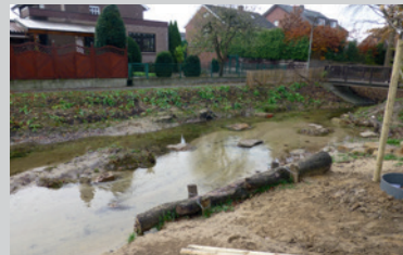
Eigendynamische Entwicklung durch Rückbau von Sohl- und Uferverbau Wieninger Bach, Warendorf-Hoetmar
