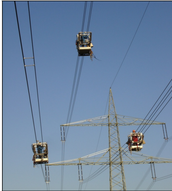
Abb. 12: Montage der Feldbündelabstandhalter mit Fahrwagen
