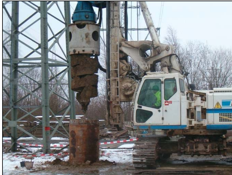
Abb.6: Bohrung für einen Bohrfahl
