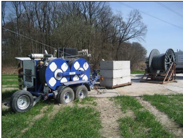
Abb. 11: Windenplatz eines 4er-Bündel-Seilzuges
