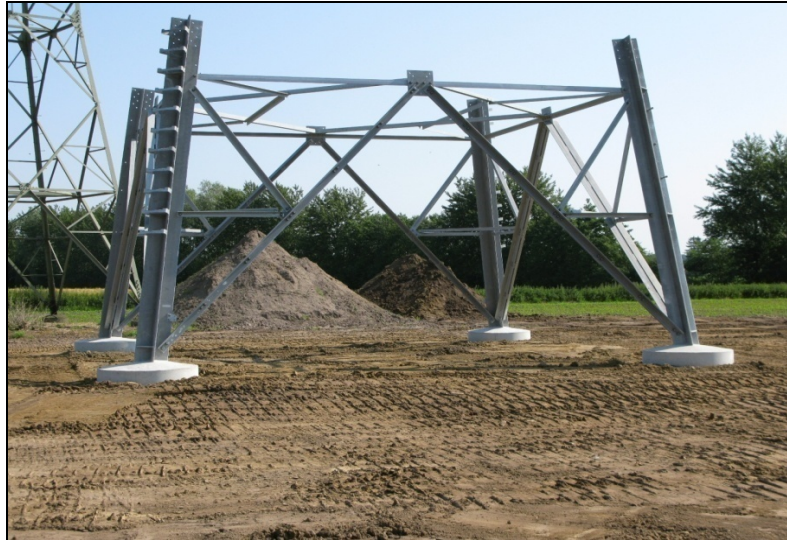
Abb. 7: Montierter Mastfuss
