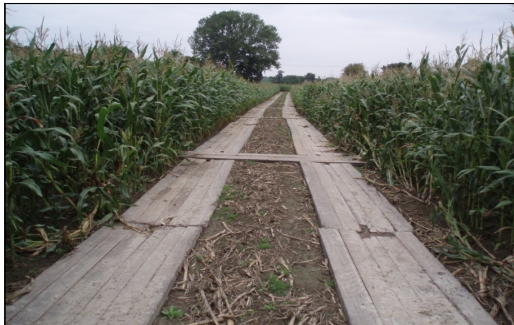
Abb. 3: Temporäre Zuwegung über Fahrbohlen
