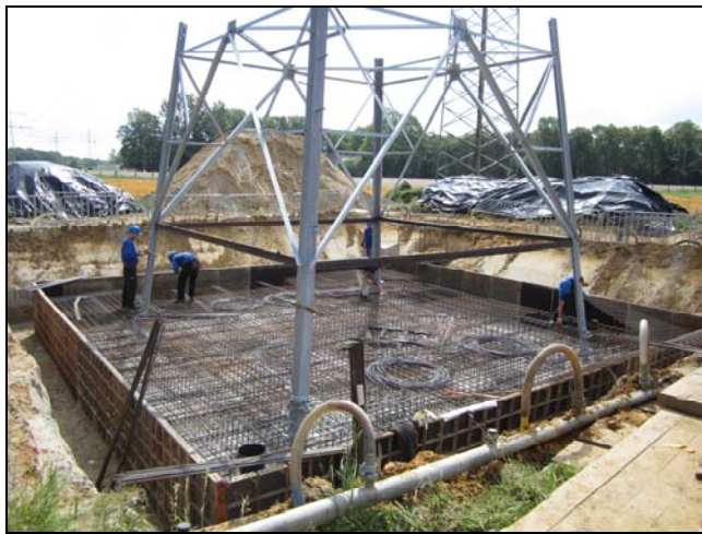
Abb. 5: Montage der Fundamentbewehrung
