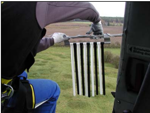
Abb. 2: Montage einer Vogelschutzmarkierung
