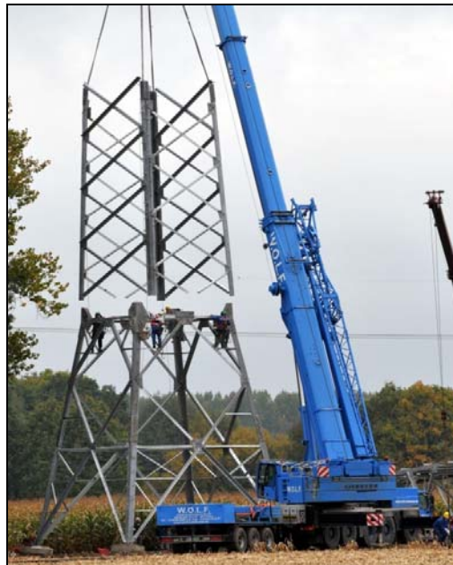
Abb. 8: Mastmontage (Stocken)
